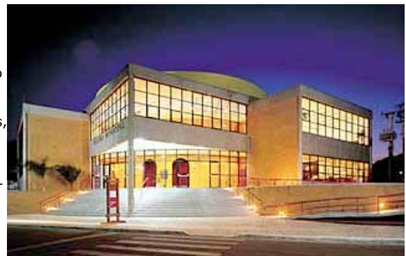
A "caixa" de concreto, aço e tijolo aparente envolve palco e platéia, em formato circular
