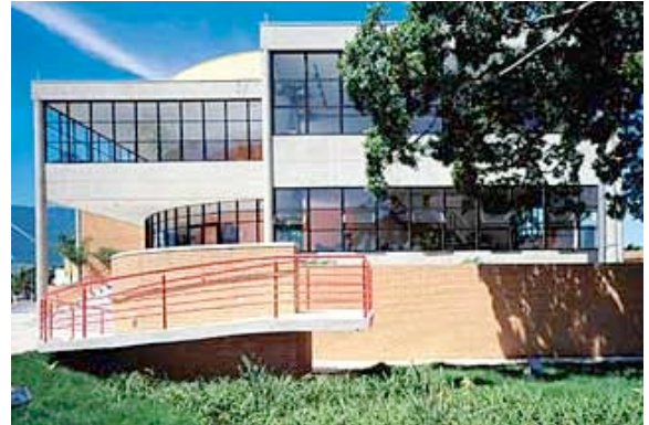
Fachada em dois ângulos: escadaria e rampa para deficientes
