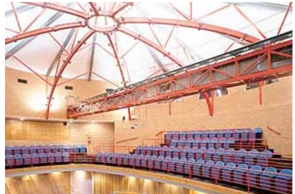
Cobertura metálica espacial sob laje maciça e isolamento acústico lateral evitam a entrada e a saída de sons
